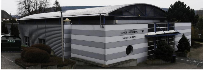
L'espace Saint-Laurent, âgé d'une vingtaine d'années, va faire l'objet de travaux de rénovation. PHOTO DNA
